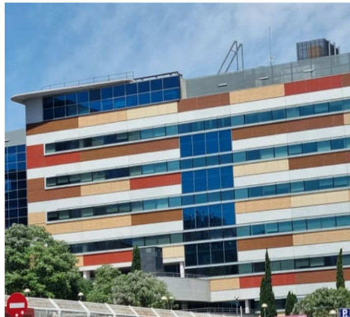
Rehabilitación de edificio en las Tablas. Madrid.
